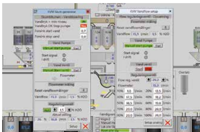
Indstilling af de forskellige parametre i skumbitumensystemet.
